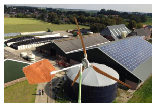
Energieneutrale boerderij (FrieslandCampina)
